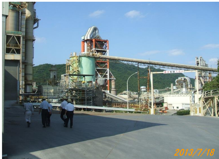
住友大阪セメント高知工場視察状況写真
